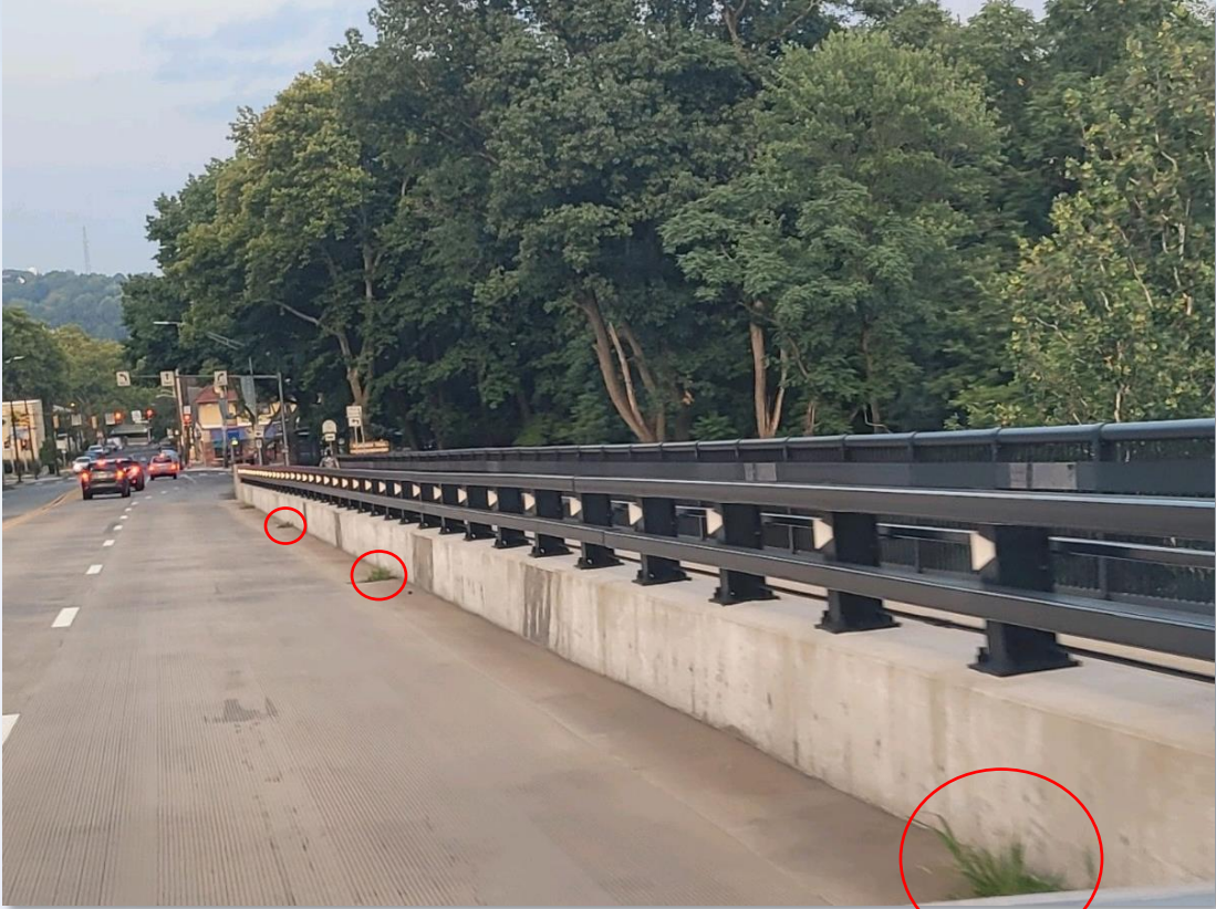
New Fern Hollow Bridge (August 2024)
